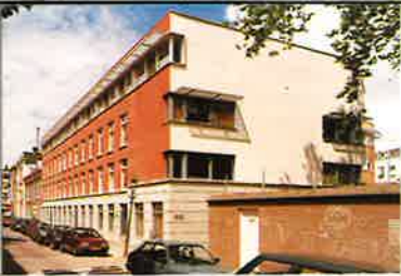
Studentenbuisvesting Bilderdijkstraat Den Haag (Geurst en Schulze architecten)
